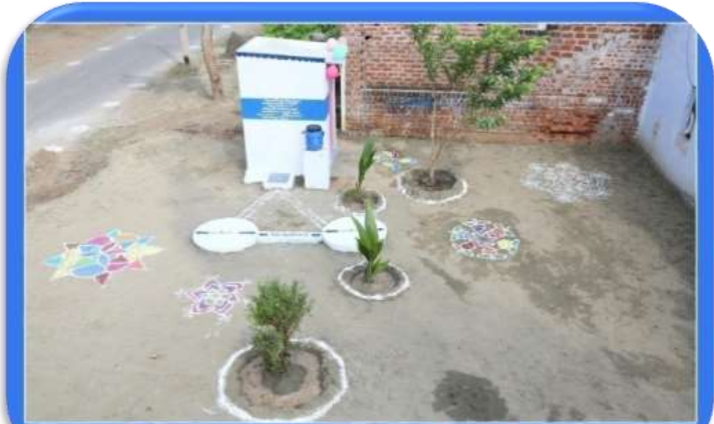
SBM (G) - IHHL TOILET (TANK MODEL)
