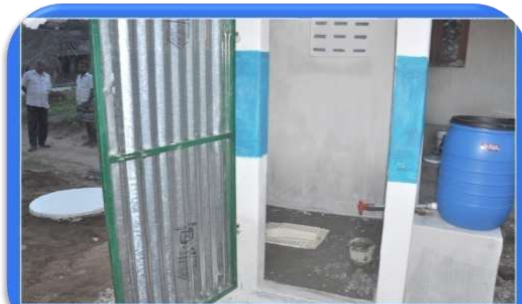
SBM (G) - IHHL TOILET (TANK MODEL)
