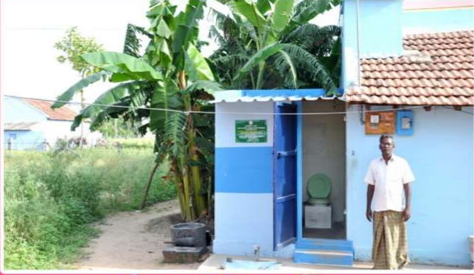
தனிநபர் இல்ல கழிப்பறை பயனாளியின் பெயர் - மணி ஊராட்சி ஒன்றியம் - நங்கவள்ளி ஊராட்சி - ஆவடத்தூர்
