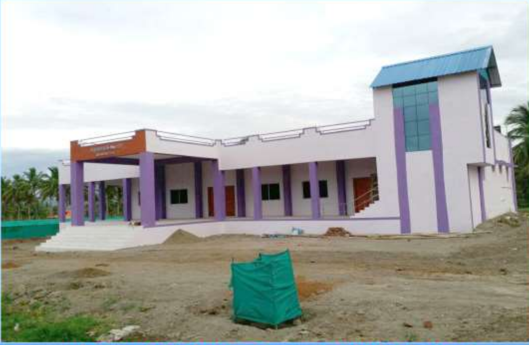
தன்னிறைவுத் திட்டம் 2015-16 சமுதாயக்கூடம் கட்டிடம் கட்டுதல் கோணகாபாடி ஊராட்சி மதிப்பீடு ரூ.60.00 இலட்சம் தாரமங்கலம் ஊராட்சி ஒன்றியம்
